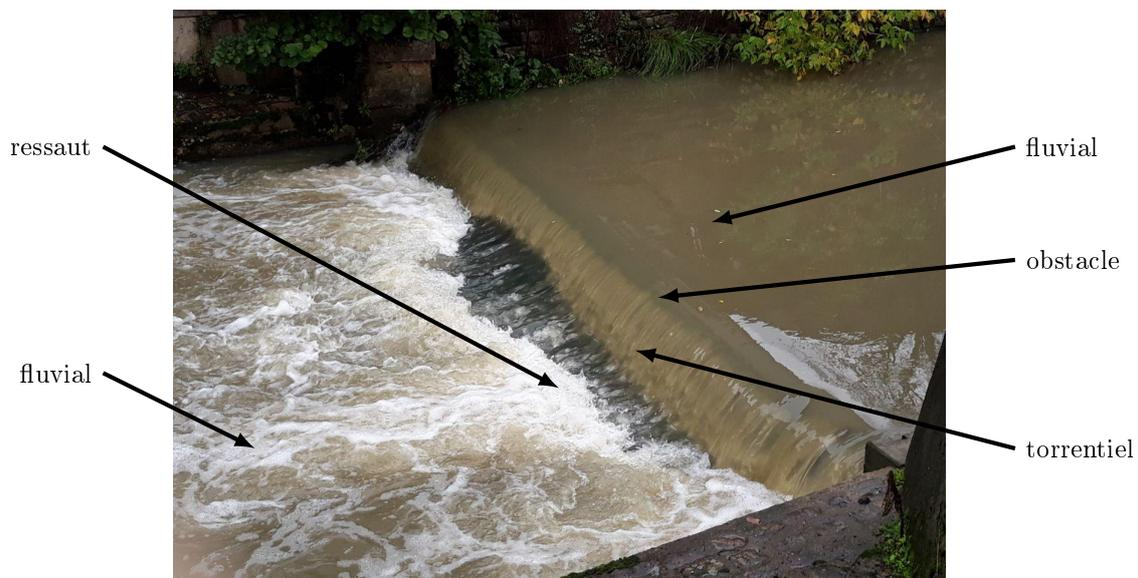
**Figure :** un ressaut hydraulique sur la Reyssouze à Bourg-en-Bresse (voyez-vous où?) : l'écoulement en amont est fluvial, il devient torrentiel au passage de l'obstacle puis redevient fluvial par un ressaut hydraulique. Absolument superbe.
